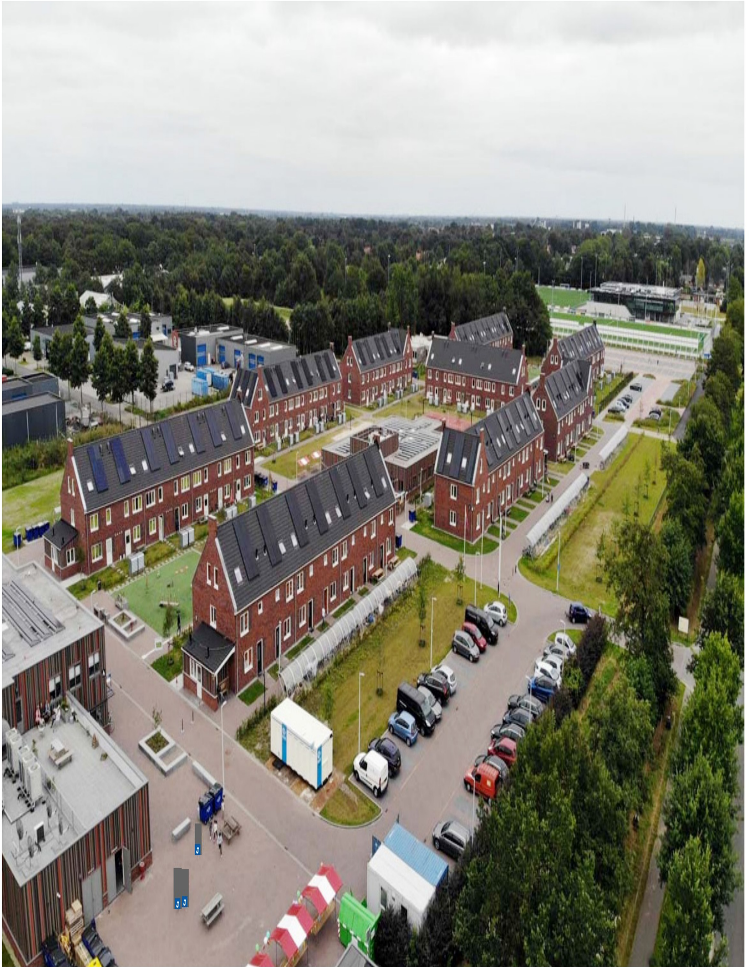
referentie nieuw gerealiseerd AZC traditionele bouw: gezinslocatie Burgum
